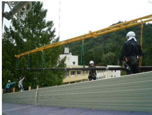
やね ざいりょう だい こうしゃ うしろ おお 屋根の材料は第3校舎の後ろから大きなクレーンであげられます
