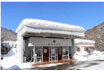
駐車場から見た玄関
